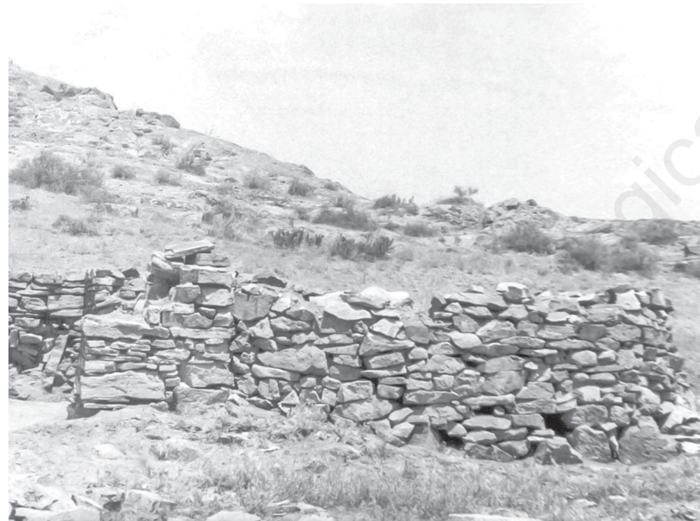
14. Шошала Кладовая Closet
